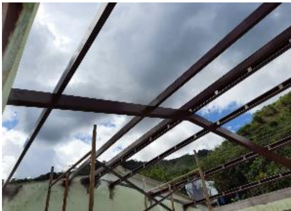
Foto 7. Instalación de estructura metálica
