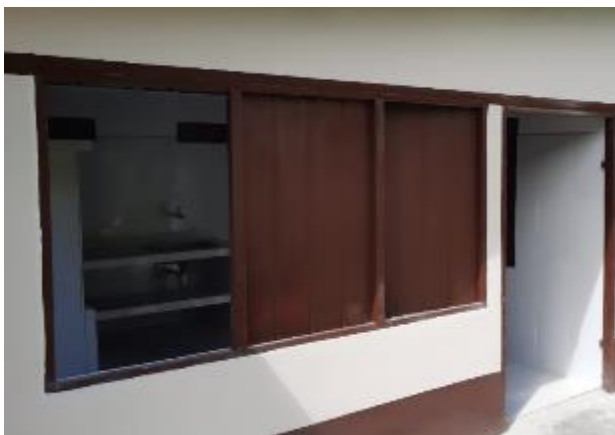
Foto 5. Pintura en carpintería metálica
