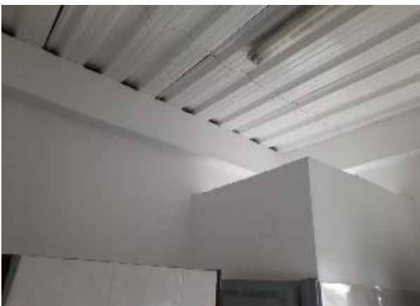
Foto 9. Aplicación de pintura vinilo
