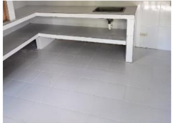
Foto 2. Instalación de enchape de piso y mesón
