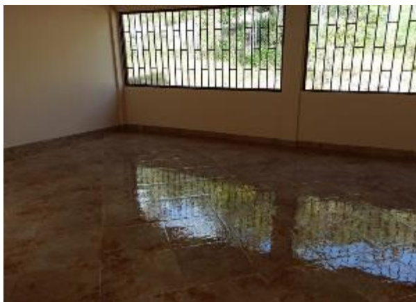
Foto 10. Instalación de enchape en aula de clase
