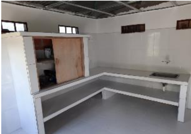
Foto 1. Instalación de enchape de pared
