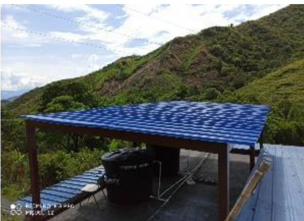
Foto 11. Instalación de tanque de almacenamiento de agua
