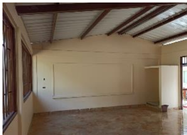
Foto 12. Pintura interna en muros de aula
