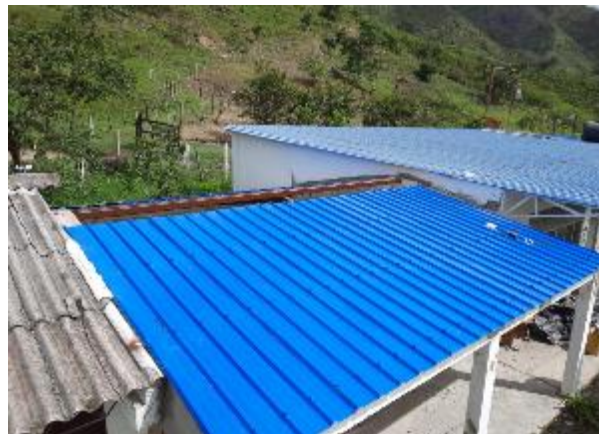
Foto 8. Instalación de cubierta termoacústica UPVC
