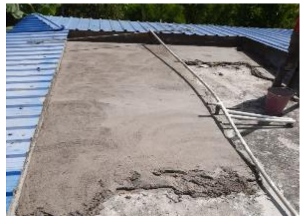
Foto 6. Fundida de alisado en placa de unidad sanitaria
